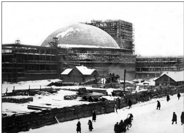
Строительство Дома науки и культуры в 1933 г.
