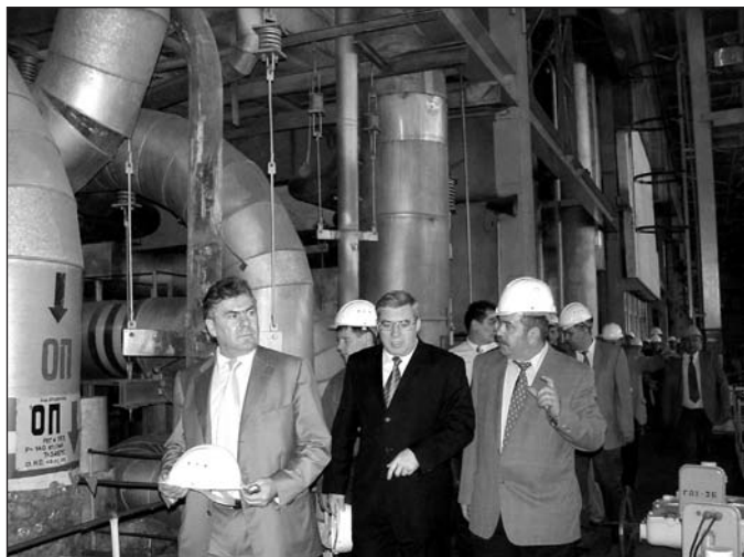
К.К. Гиберт знакомит губернатора В.А. Толоконского с ходом строительства шестого энергоблока ТЭЦ-5
