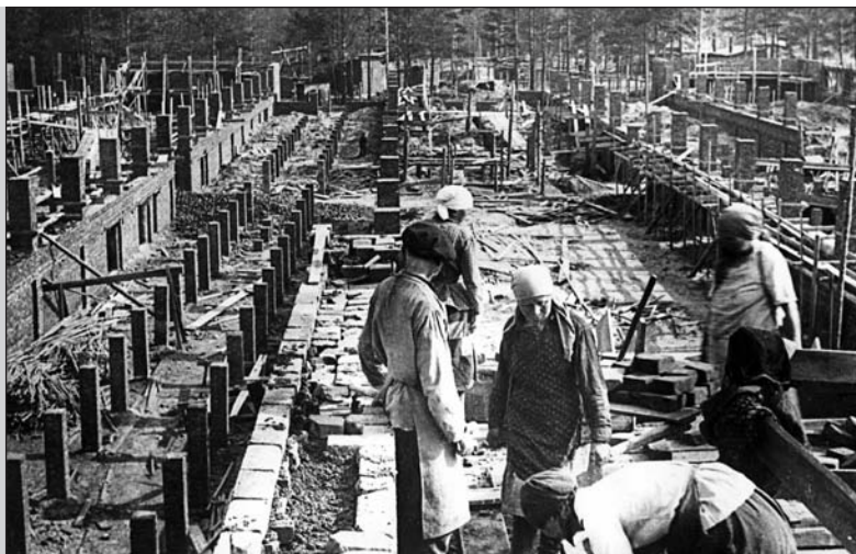
Строительство обувной фабрики
